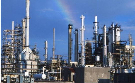
Oil refinery སྤུལ་བཅག་བཞེ་གྲ།
