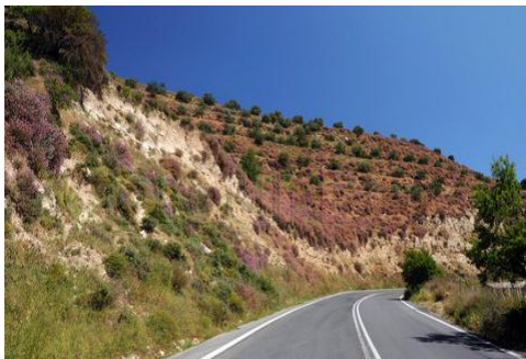
Motor road འཁོར་ལམ།
